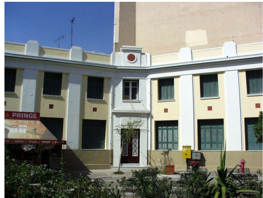
εικ. 2 Γραφεία Α' Δημοτικής Κοινότητας στη θέση της παλαιάς Αγοράς Ψυρρή. Φωτ. Βικτωρία Καίσαρη 2020
